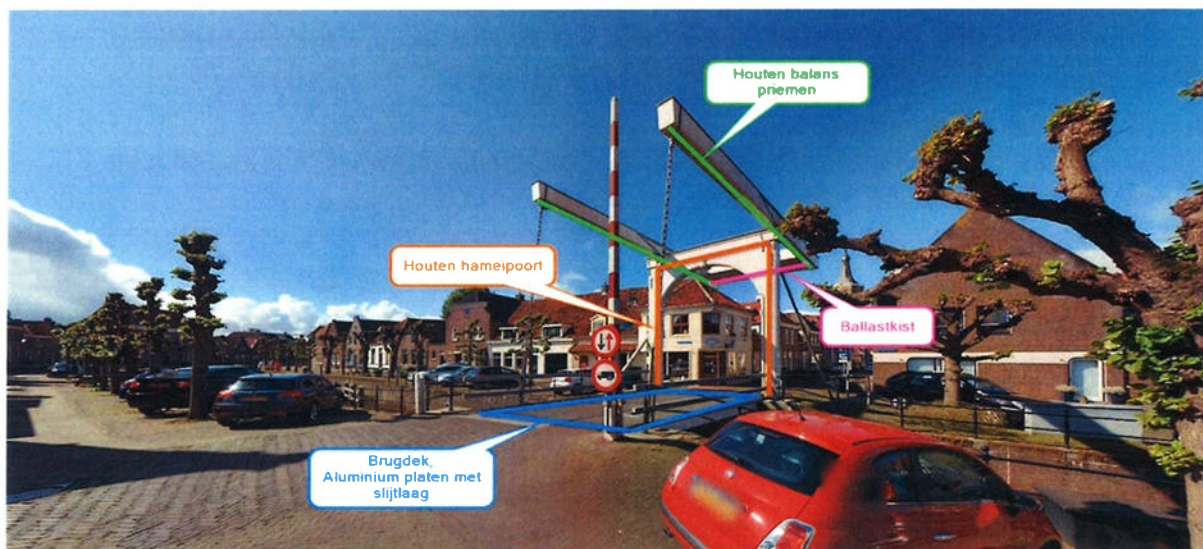
Verlaatsbrug met aanduiding van de onderdelen:
