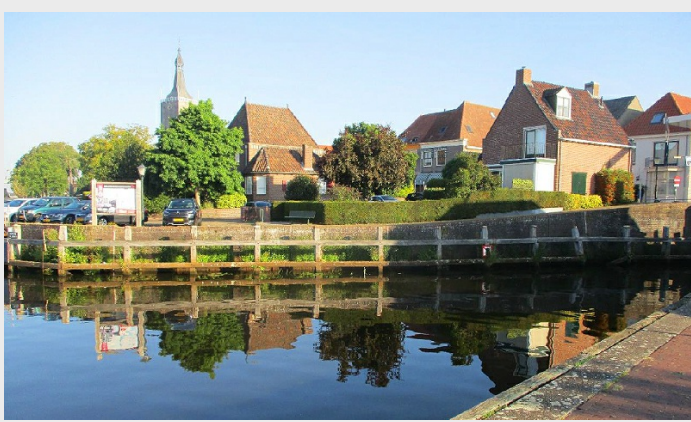
Kademuur en remmingwerk zijde Meijersbolwerk
